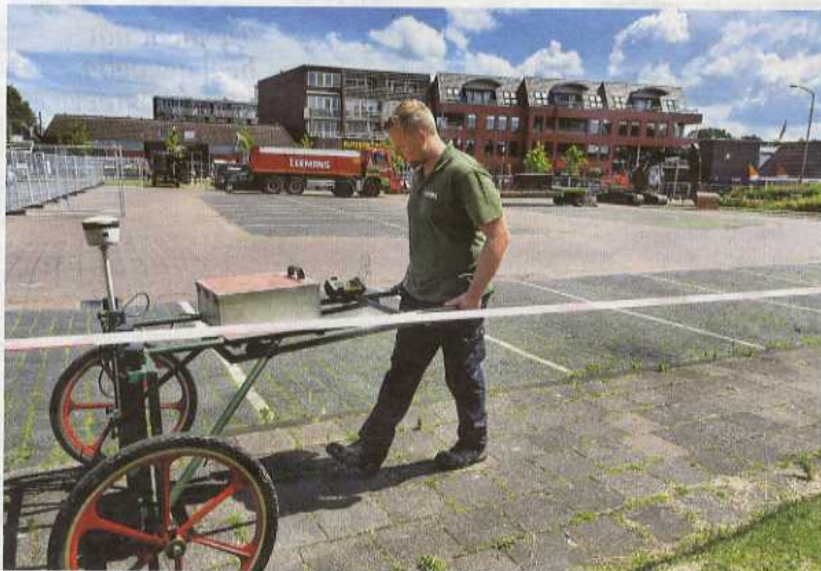
Jeroen Davenschot van Leemans Speciaalwerken zoekt met speciale apparatuur het afgezette deel van de parkeerplaats af naar de vliegtuigbom uit de Tweede Wereldoorlog. FOTO PETER WASSING
