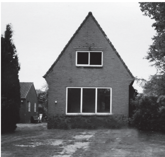
De herstelde woning van het gezin De Vries aan de Heerenstreek 5
