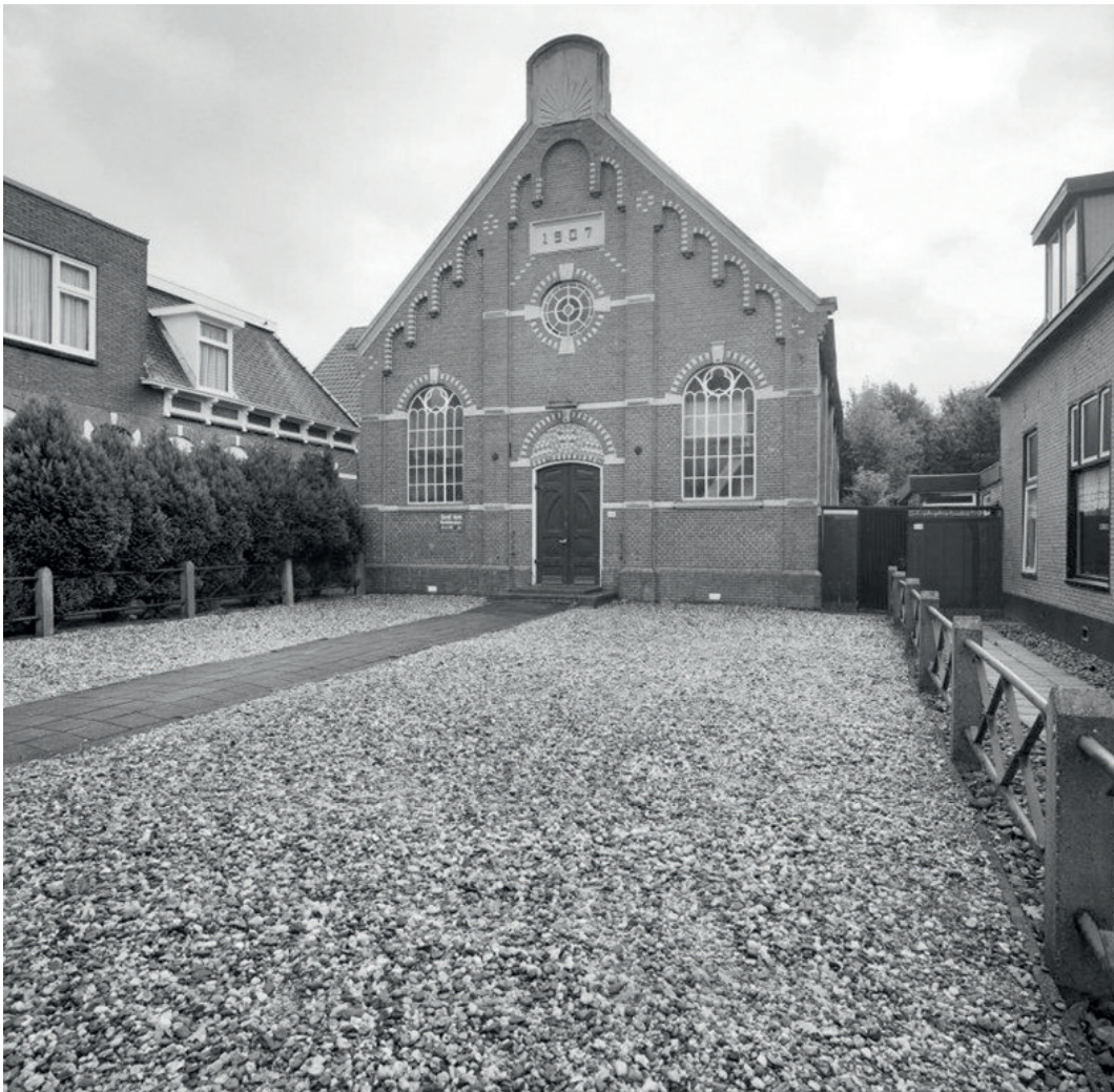
Gereformeerde kerk Nieuw-Weerdinge
